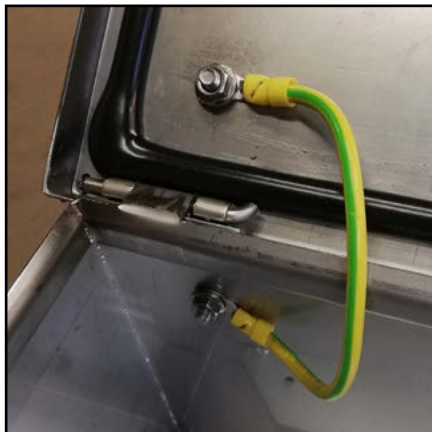
7. Détails de la mise à la terre et du joint
